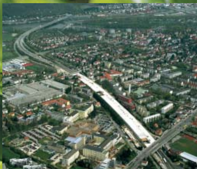
Bau der Einhausung, 1999-2001
